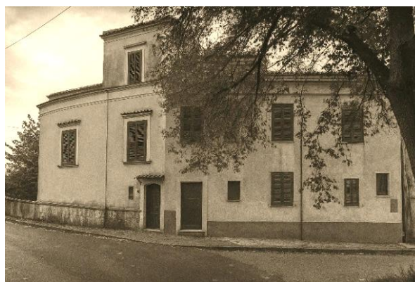
Casalnuovo, contrada Paterno, fabbricato di proprietà di Aurelio D’Acunzo.
