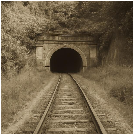
Località Codola, galleria ferroviaria dell'Orco.
