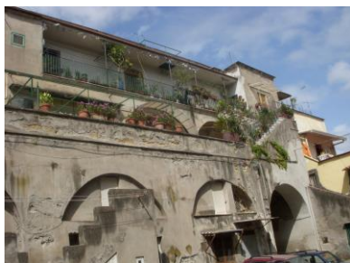
Depositi riadattati ad abitazioni
